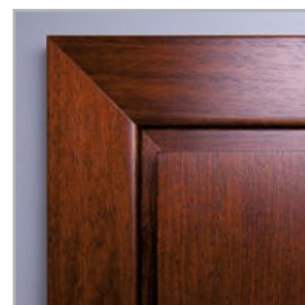
łączenie opasek pod kątem 45°
