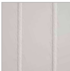
frezowanie na powierzchni skrzydła
